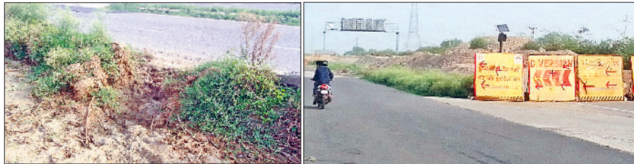
नारनौल। निर्माण कंपनी की ओर से बनाई गई दीवार व टूटी मेड़, जिससे बरसाती पानी खेत में पहुंचा तथा गांव गहली के पास निर्माणधीन अंडरपास, जहां कंपनी द्वारा कार्य किया जा रहा है।
